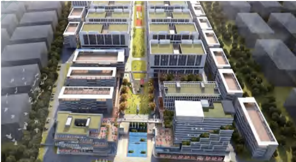
顺德中集智谷项目
