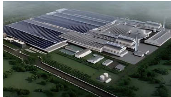
沙巴旗滨光伏玻璃电梯采购安装项目
