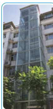
建工集团工大宿舍
